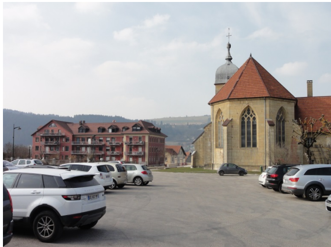
72 : Ancienne usine réhabilitée
